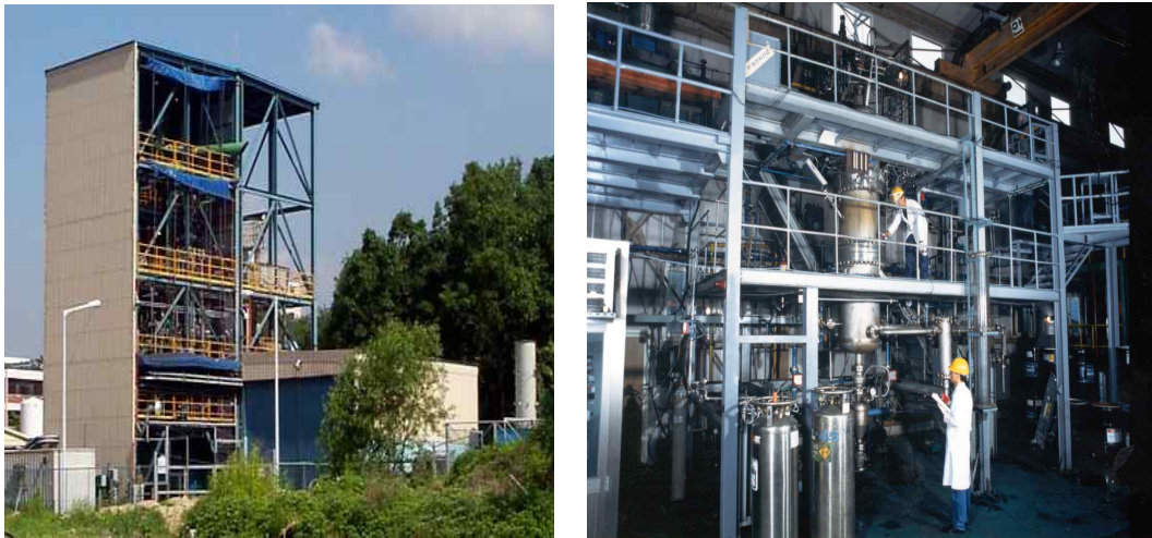
그림 2. 3톤/일급 건식 가스화기(좌)와 1톤/일급 습식 가스화기(우) 전경
