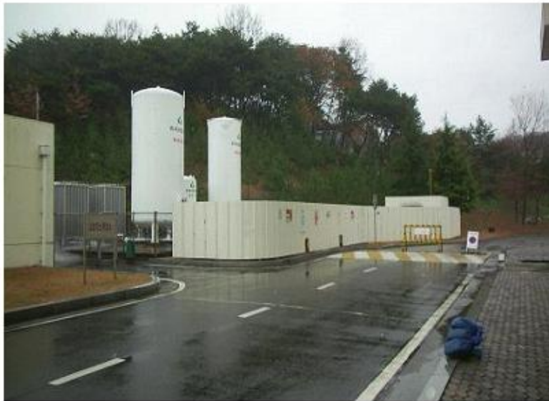
● 위험물 저장시설 2중 방호 울 설치
