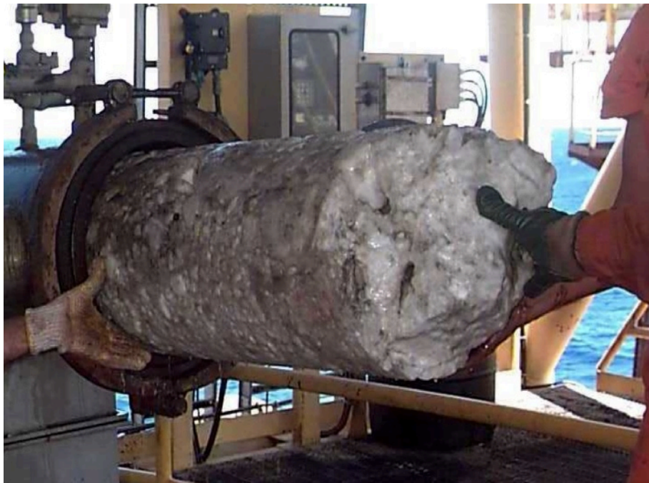
생산시설을 폐색시킨 가스 하이드레이트 블록 (Petrobras)
